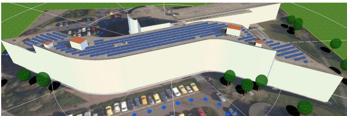
Figuur 3 – Zonnepanelen op het Stadhuis Purmerend”
